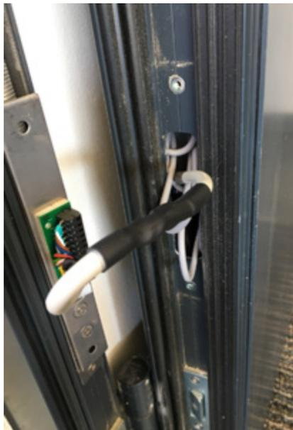
Tirez sur le câble adaptateur jusqu'à ce que le CO micro (dans un boîtier ou une gaine thermorétractable) soit sorti.
